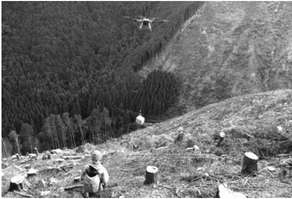
写真-6 資材を運搬する大型ドローン
